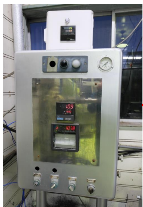
その他改善 1 殺菌制御盤の点検
