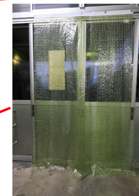
その他改善 3-2 防虫カーテンの設置
