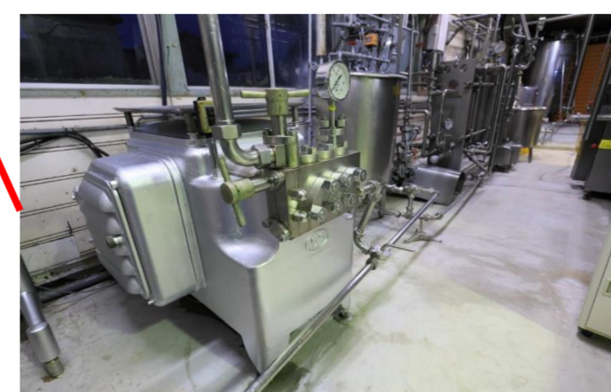
その他改善 4 製造室床の補修
